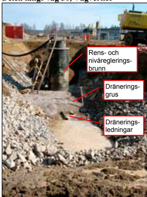
Figur 20. Pågående anläggning av uppsamlingsanordning längs väg 50.
