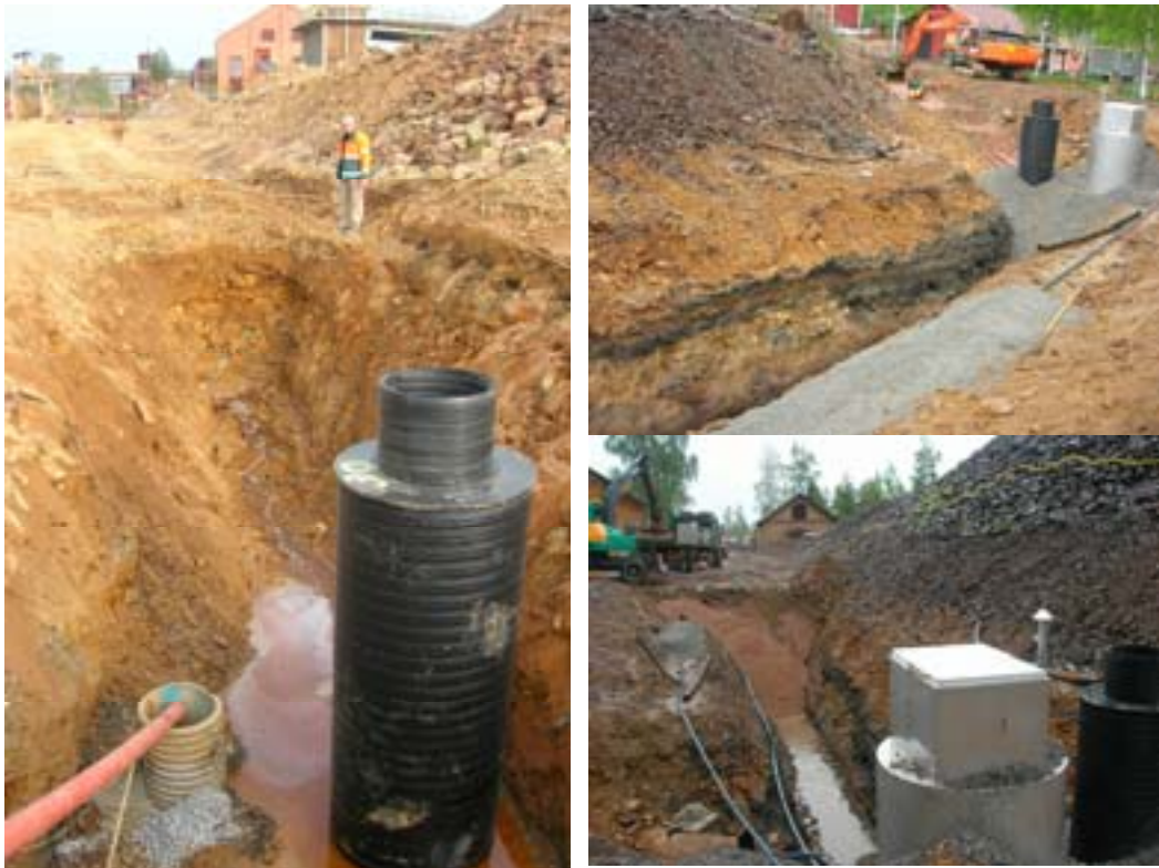
Figur 21. Bilder från anläggning av uppsamlingsledningar, brunnar och pumpstation T60, sommaren 2006.
