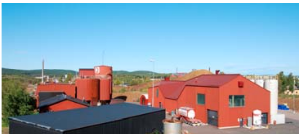
Figur 4. Rödfärgsverket (till vänster) och den nya gruvvattenreningsanläggningen (till höger).
