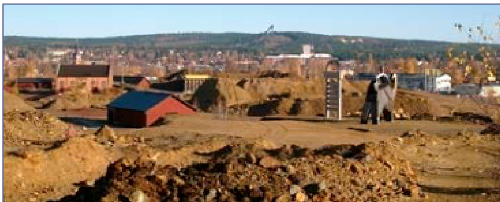
Figur 5. Upplag av rödfärgsråvara söder om rödfärgsverket.
