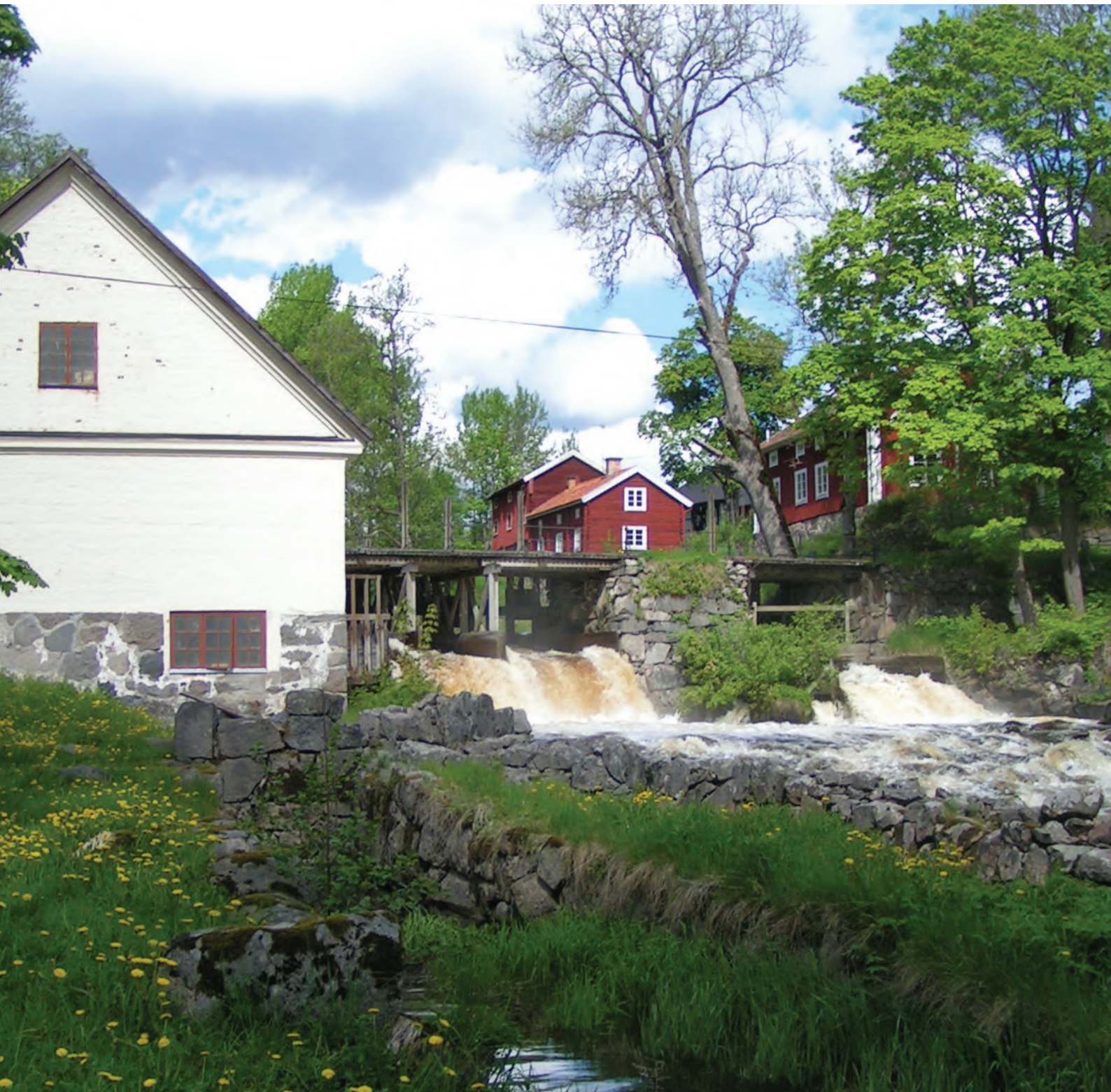
Figur 2. Järle Kvarn och damm. Från vänster till höger: kvarnbyggnaden, mellersta och vänstra utskovet. I bakgrunden, uppströms dammen, ligger bland annat den så kallade Linnéstugan där Carl von Linné övernattade i mitten av 1700-talet. Norconsult, 2010.
