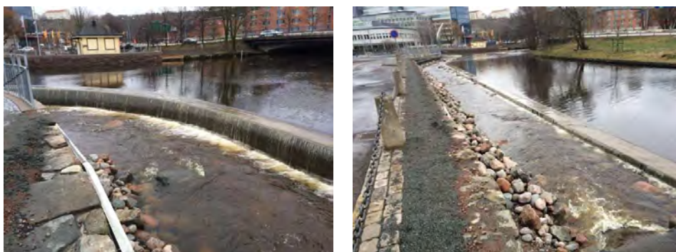
Figur 24. Exempel på inlöp med avskiljande spont beklädd med betong. Vid Järle kvarn får dock inlöpet en något större bredd och blir 2-sidigt för att avbörda högre flöden.
