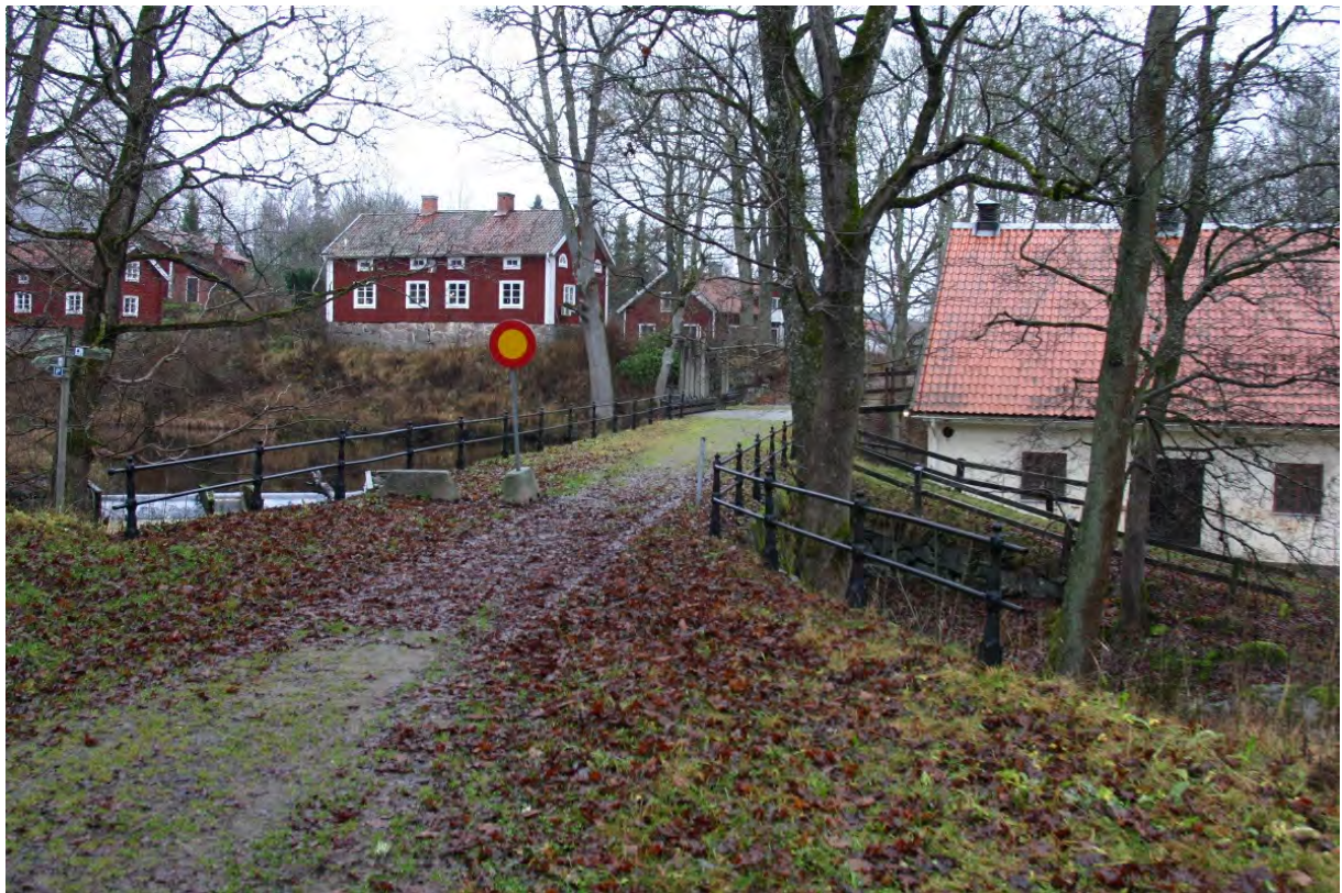
Dammen och broarna mot norr. Kvarnen syns nere till höger. Valvbron finns under vägmärket på bilden.
