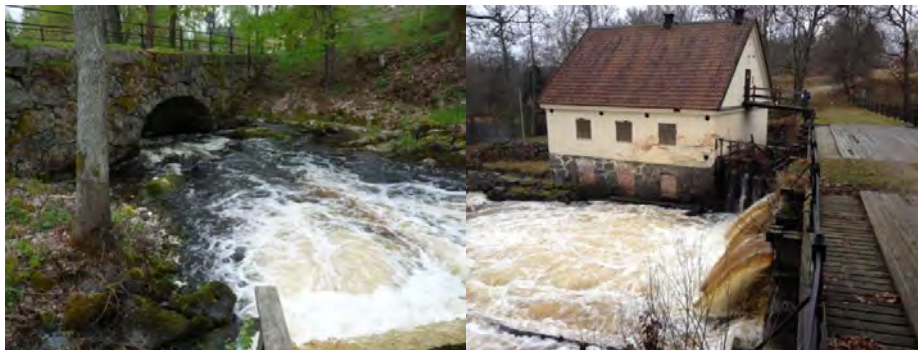
Figur 12. Sikt från befintligt skibord med fiskväg, ner mot stenvalvsbron.
