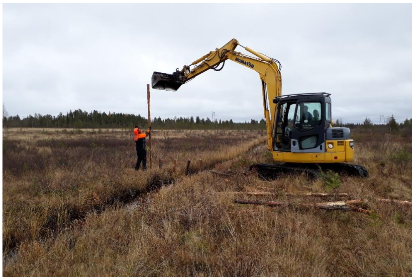
Igenläggning av diken
