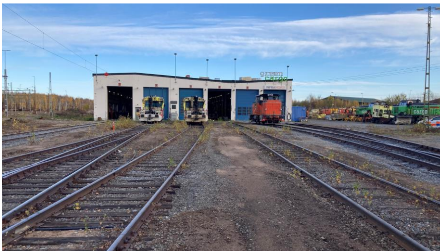
Figur 13. In situ-sanering i Boden. Saneringen är i full gång. (foto: Trafikverket).
