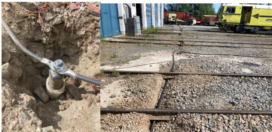
Figur 12. In situ-sanering i Boden. Elektrod med koppling samt kablar som läggs ut för att senare grävas ned (foto: Trafikverket).
